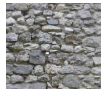
Enduit à pierres vues
