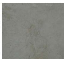
Enduit couvrant à la chaux
